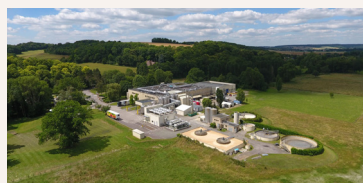
Fromagerie Boursin de Croisy-sur-Eure
