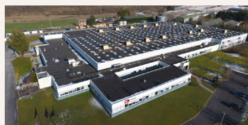
Usine Construction Specialties de Pacy-sur-Eure
