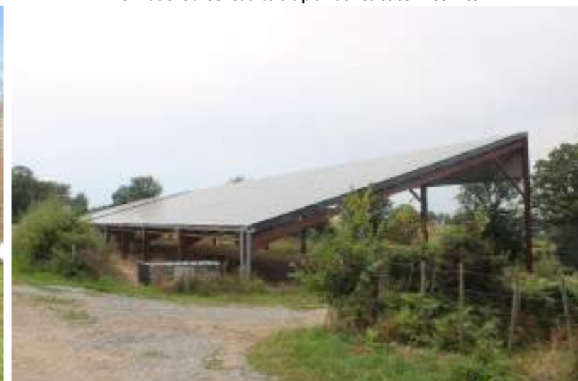
Bâtiments agricoles isolés
