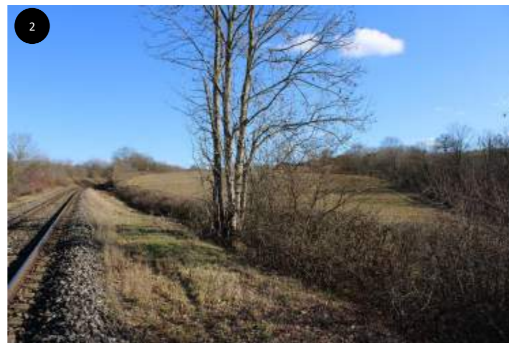
Figure 65 : Perceptions visuelles depuis le Viaduc de la Boule – Echassières
