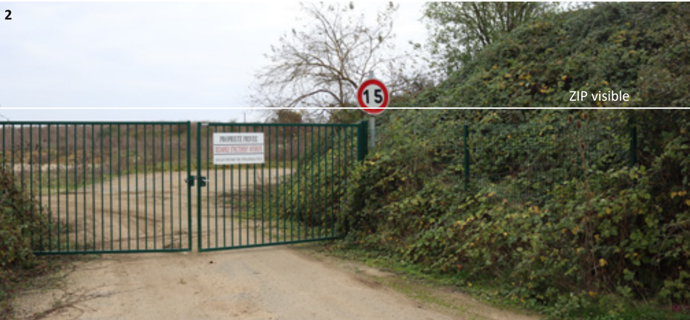
Photographie 32. Vue depuis la D50, au droit de l'entrée du site
