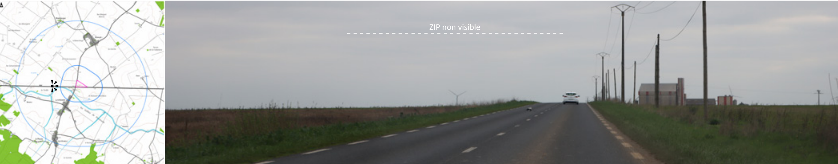
Photographie 22. Vue en direction de la ZIP
