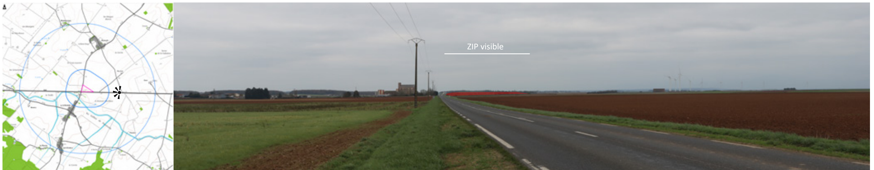
Photographie 21. Vue en direction de la ZIP
