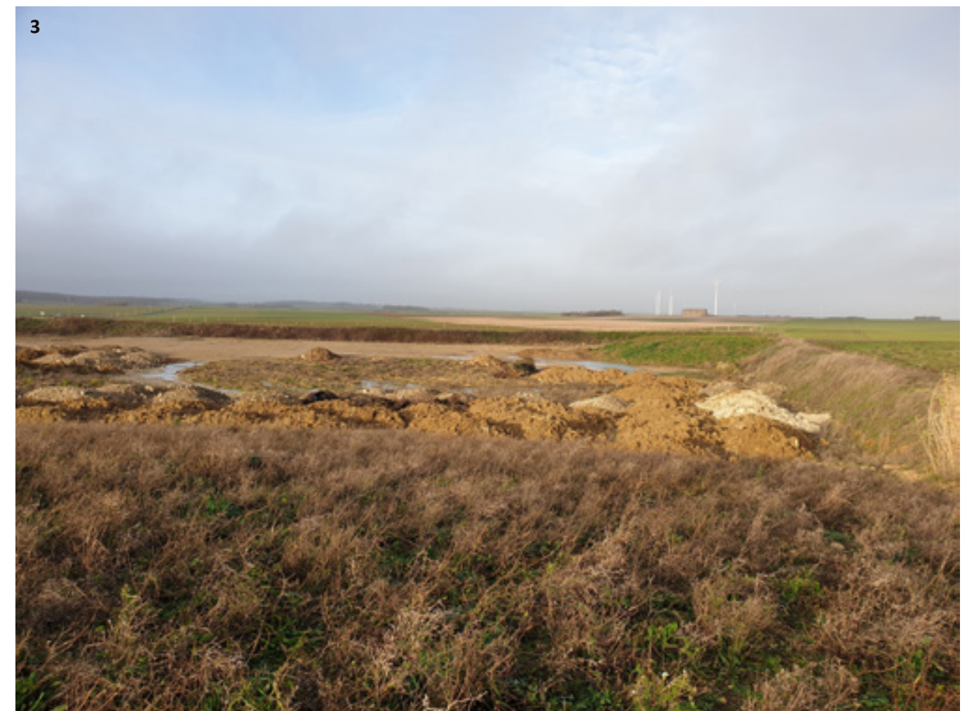
Photographie 37. Vue sur le merlon nord de la ZIP
