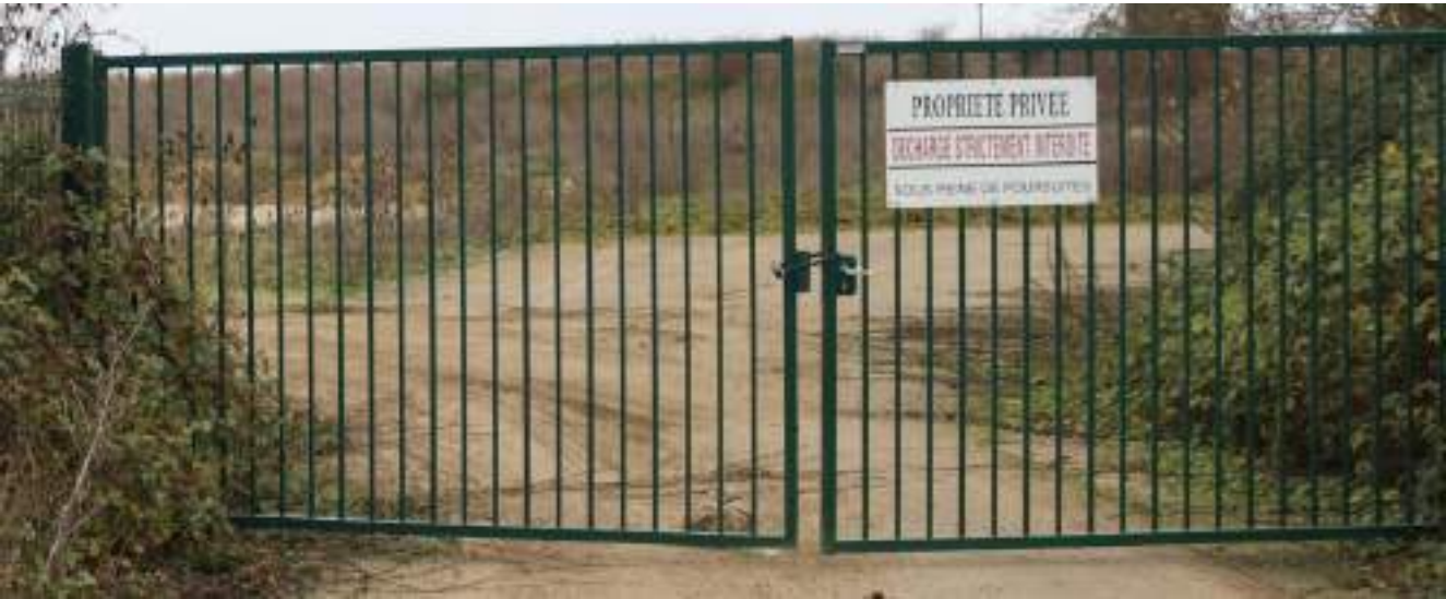
Photo 54. Portail existant sur site actuellement
