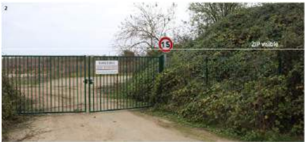
Photo 48. Vue depuis la D50, au droit de l'entrée du site
