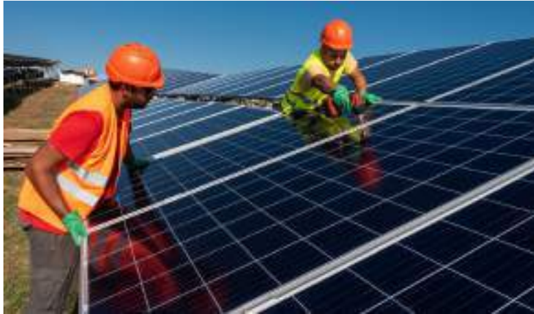
Photo 56. Pose des modules PV sur les tables
