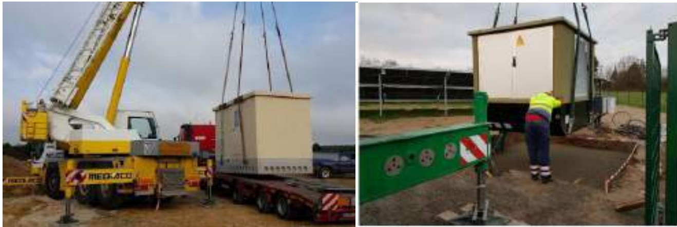
Photo 57. Grutage des postes électriques sur site
