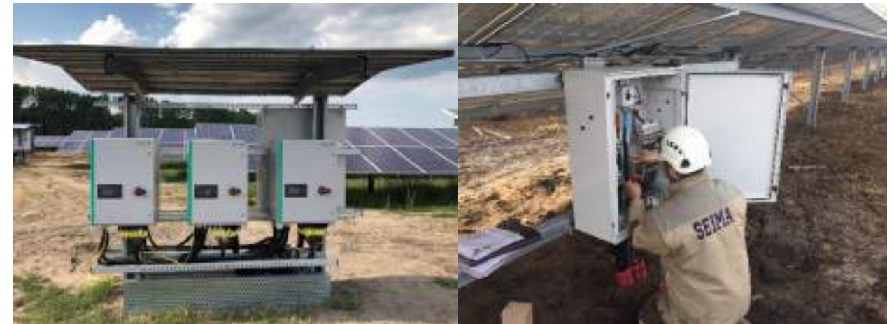
Photo 58. Pose et câblage des boîtes de jonction et/ou des onduleurs
