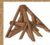
Maquette 4 et 5 : Barbe de panne et repos d'arêtier
