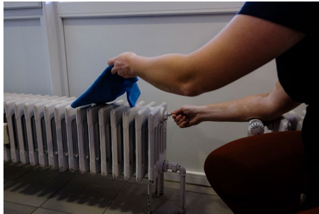
workshop chauffages ontluchten
