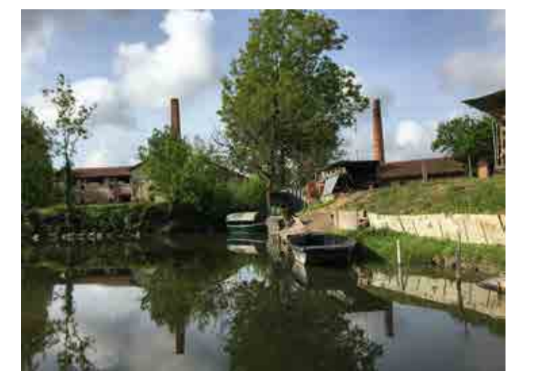
La Briqueterie avec deux cheminées vues depuis le bief du Roseau
