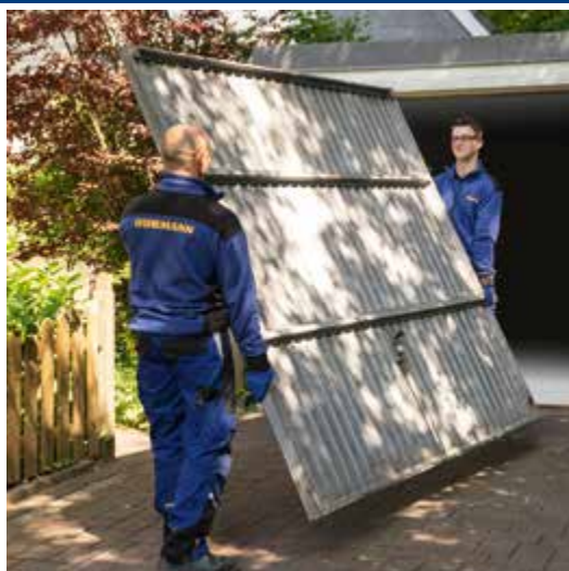
Ausbau und umweltgerechte Entsorgung
