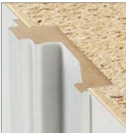
In bester Tischlertradition mit eingelegter Profilleiste in einer Vertiefung im Türblatt
