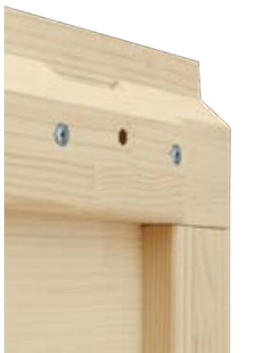
Verstärkung an den Lamellenenden
