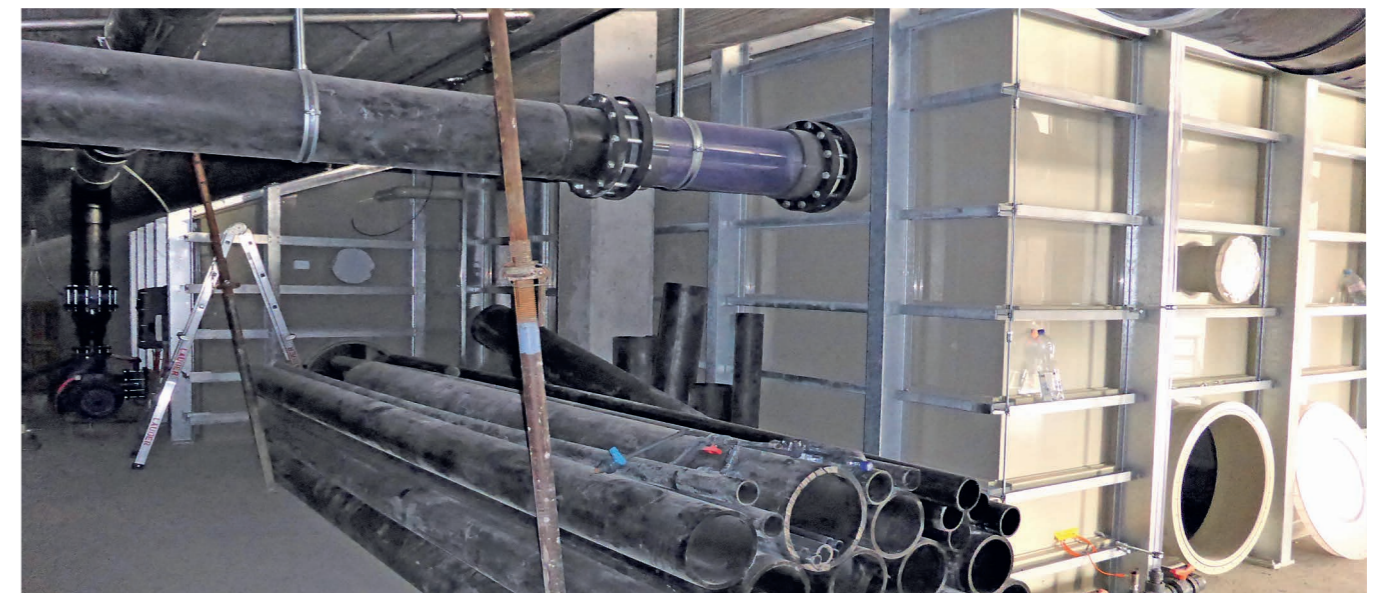
80 m 3 und 90 m 3 – PP Ausgleichstanks L 6.0 x B 5.0 x H 3.3 m
