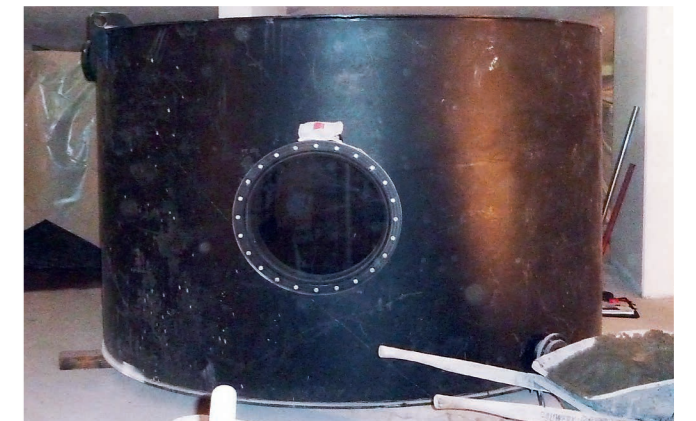
12 m 3 – PE Ausgleichstank D 3.0 x H 1.8 m
