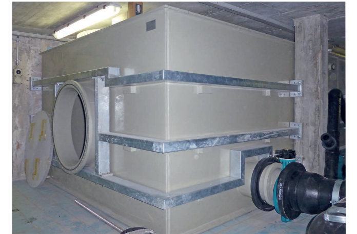
20 m 3 – PP Ausgleichstank L 6.0 x B 2.5 x H 1.4 m
