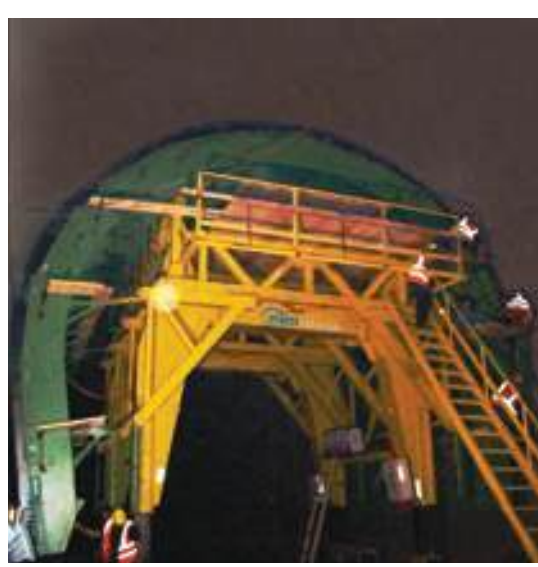
YEMEN OTOYOL PROJESİ Tünel Kalıp İmalatı - Yertaş İnşaat YEMEN HIGHWAY PROJECT - Tunnel Formwork Manufacturing - Yertaş Construction
