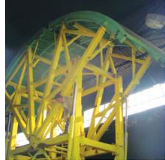
YERTAŞ İNŞAAT Dim Barajı Baca Kalıbı yan odacığı YERTAŞ CONSTRUCTION Dim Dam Smokestack Formwork Side Chamber
