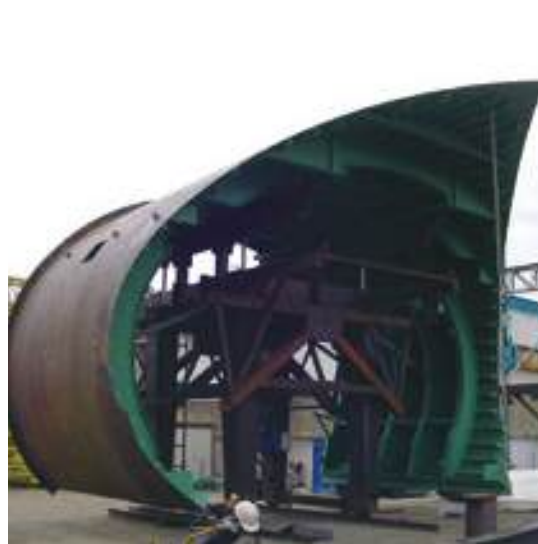
KARTAL KADIKÖY METRO İSTASYONLARI Tünel Kalıbı KARTAL KADIKÖY (İSTANBUL) SUBWAY STATIONS - Formwork
