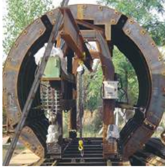
TİNSA İNŞAAT - Bursa Ak Enerji HES Kemer ve İnvert Kalıbı TİNSA CONSTRUCTION - Bursa Ak Energy HEPP Arch and Invert Formwork
