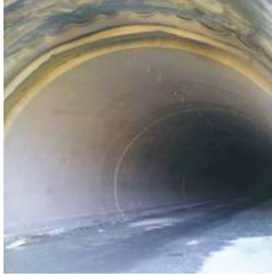
LİMAK İNŞAAT - Pozantı Otoyolu Tünel Kalıbı ve Beton Kaplama İşİ LİMAK CONSTRUCTION - Pozantı Highway Tunnel Formwork and Concrete Pavement Works
