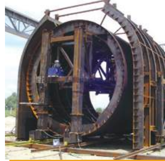
BEREKET ENERJİ - Sivas Koyulhisar Aç / Kapa Tünelleri BEREKET ENERGY - Sivas Koyulhisar Open / Close Tunnels
