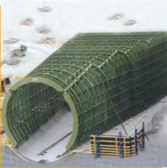
YÜKSEL İNŞAAT A.Ş. - Karkamış Barajı Geçiş Tüneli YÜKSEL CONSTRUCTION CO. Karkamış Dam Transmission Tunnel
