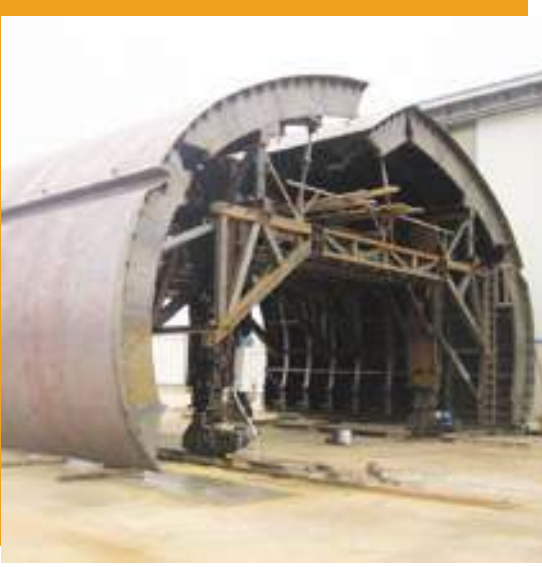
LEVENT/HİSARÜSTÜ RAYLI SİSTEM PROJESİ Metro Tünelleri Kalıp İmalatı ve Montajı - Ant İnşaat LEVENT/HISARUSTU RAILWAY PROJECT - Subway Formwork Fabrication and Erection - Ant Construction
