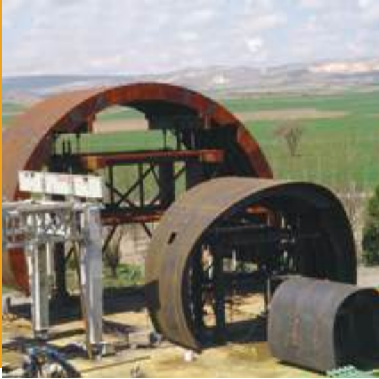
GARANTİ KOZA - ALSİM ALARKO ORTAKLIĞI İstanbul Metrosu Tünel Kalıpları GARANTİ KOZA - ALSİM ALARKO JV. İstanbul Subway Tunnel Formworks
