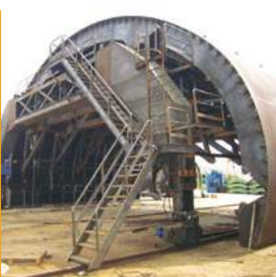
KUZEY MARMARA OTOYOLU PROJESİ - Tünel Kalıp İmalat ve Montajı - ESA İnşaat NORTH MARMARA HIGHWAY PROJECT - Formwork Fabrication and Erection - ESA Construction
