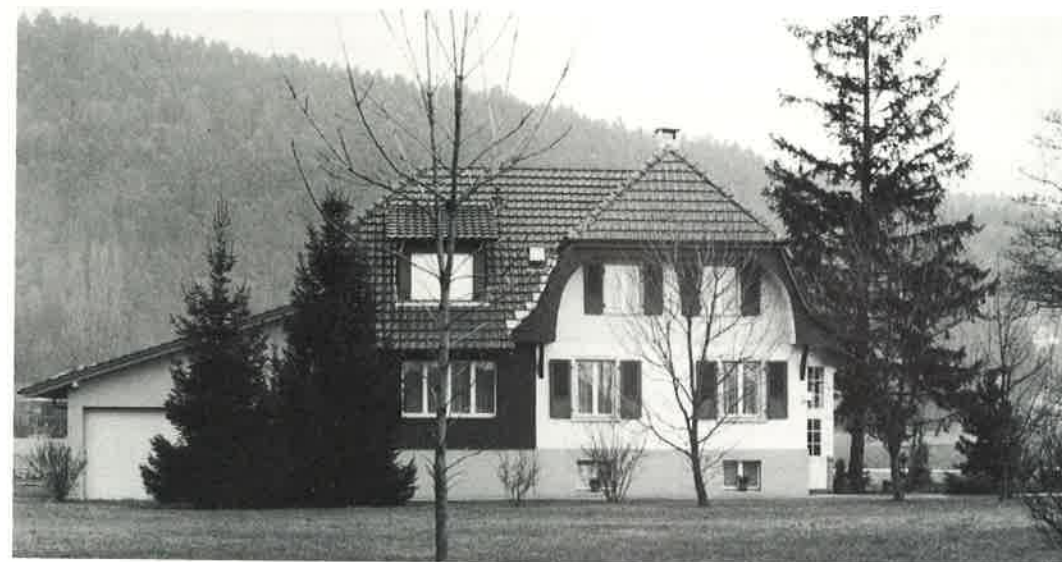
Wärterhaus in Worben nach dem Um- und Ausbau
