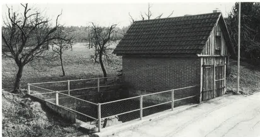
Feuerwehrmagazin in Scheuren
