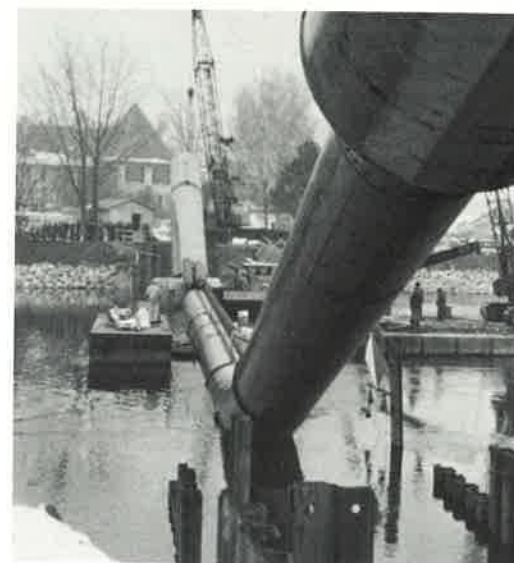
Absenkung des ARO- und SWG-Dükers im Nidau-Büren-Kanal bei der Gottstattbrücke
