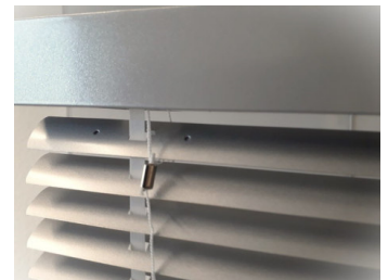
Entlastungsmodus: Behäng in der unteren Endlage, Lamellenwinkel aufgestellt (mind. 45 Grad).
