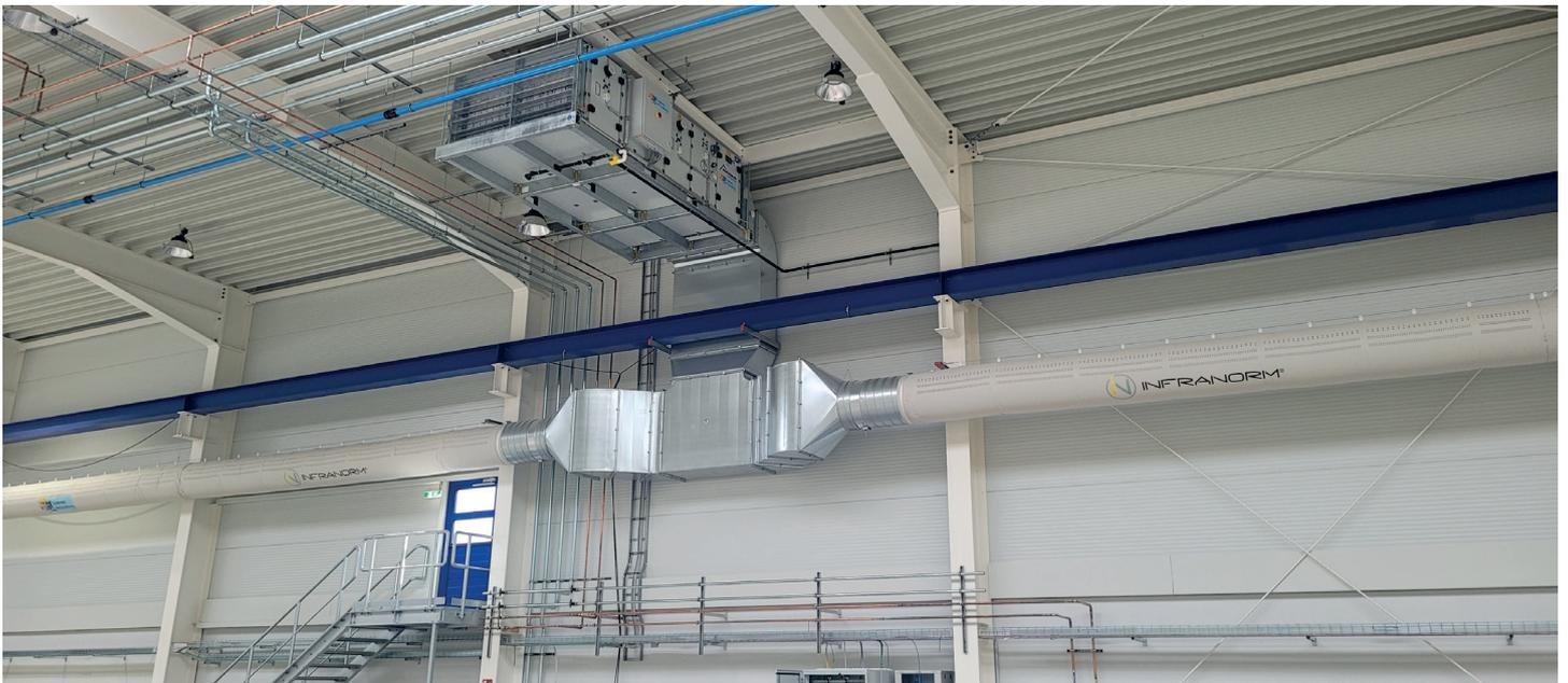
**Bild 04:** Das textile Zuluftschlauchsystem sorgt für eine zugfreie und gleichmäßige Verteilung der konditionierten Luft.
