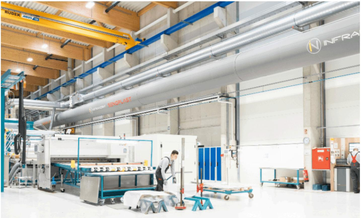
Die textilen Luftauslässe für die Lufteinbringung werden passend zur Halle geometrie individuell angefertigt. -c-MAGNA
