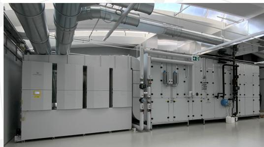
Abbildung 4: Ölrauchfilter angeschlossen an das Zentrallüftungsgerät
