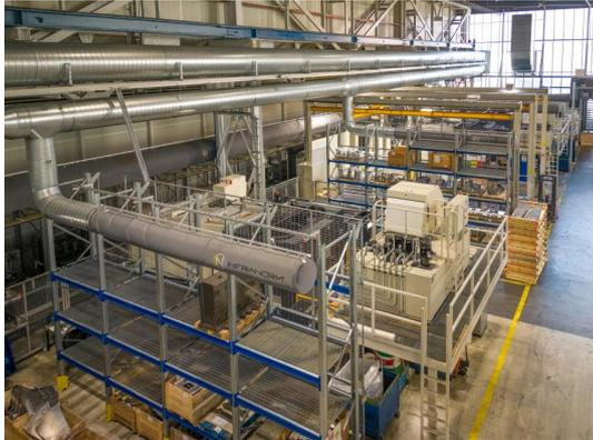
Abbildung 8: Die Lufteinbringung erfolgt zielgerichtet in Zonen mit den individuell gefertigten Textilluftauslässe.
