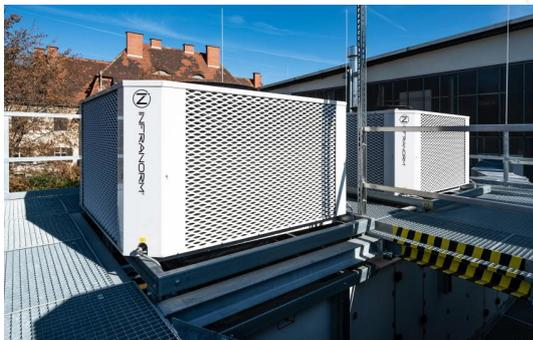
Abbildung 3: Mischluftgerät mit aufgesetzter zweistufiger adiabater Kühlung für 28.000 m³/h
