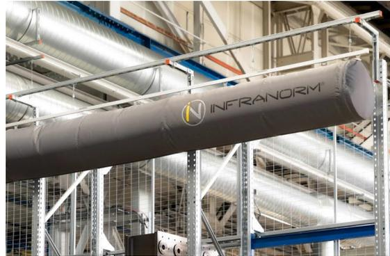
Abbildung 5: Die Textilluftauslässe für die zugfreie Zufuhr der gekühlten Frischluft.
