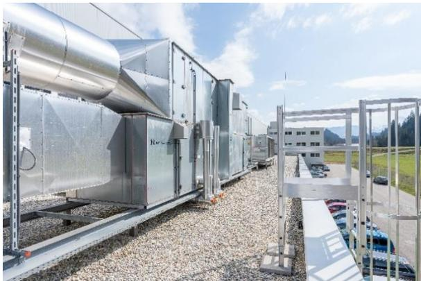
Abbildung 6: Lüftungsanlage mit Rotationswärmetauscher – Bereich Maschinenhalle
