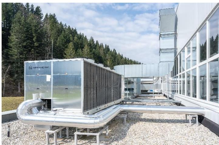
Abbildung 11: Die reversible Wärmepumpe wird hauptsächlich durch die neue Photovoltaik-Anlage am Standort Grub gespeist
