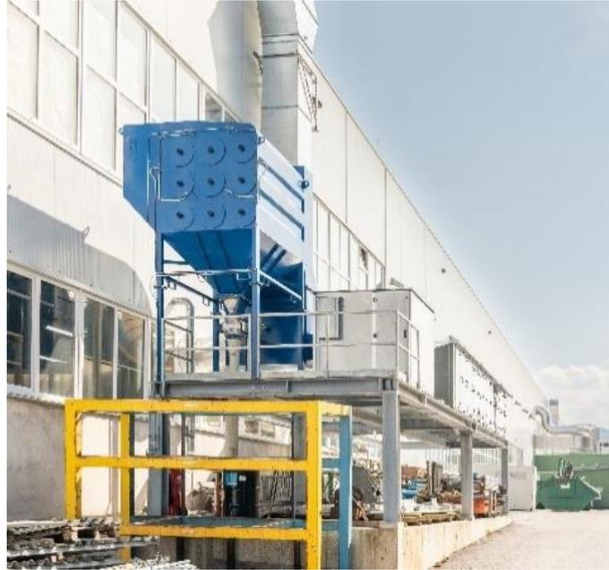
Abbildung 9: Patronenfilter mit Ablufteinheit und (im Hintergrund) Lüftungsgerät – Bereich Schleiferei
