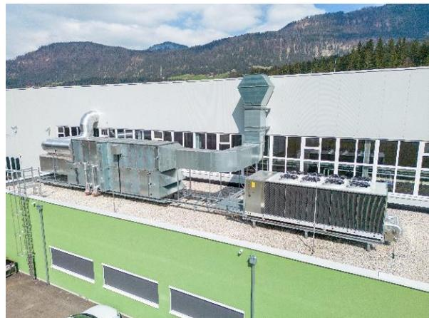
Abbildung 3: Zu- und Abluftanlage für Maschinenhallen und reversible Wärmepumpe
