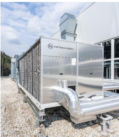
Abbildung 10: Reversible Wärmepumpe für Heizen und Kühlen des gesamten Standortes in Grub
