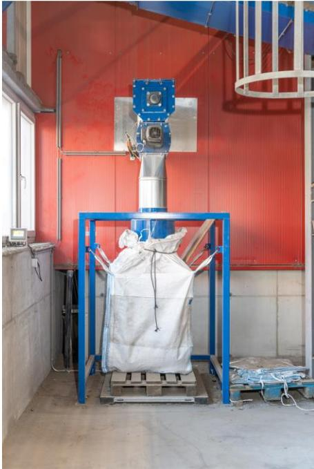
Abbildung 9: Druckentkoppelter Staubaustrag mit elektronischer Wiegeeinheit
