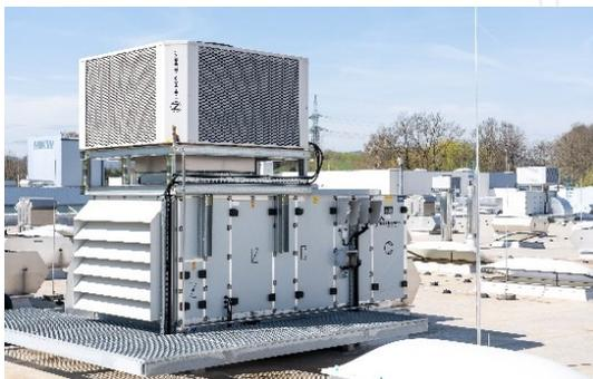
Abbildung 3: Mischluftgerät mit aufgesetzter zweistufiger adiabater Kühlung
