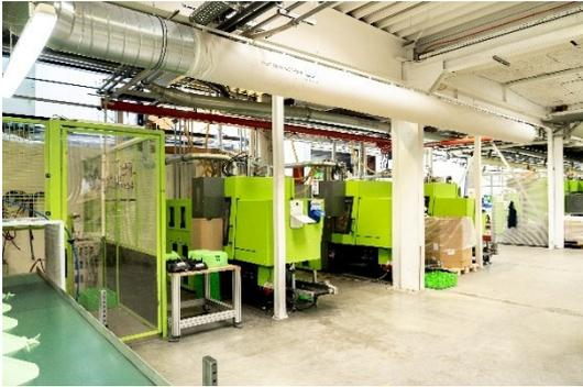
Abbildung 8: Die Lufteinbringung erfolgt zielgerichtet für die Mitarbeiter mit den individuell gefertigten Textilluftschläuchen.
