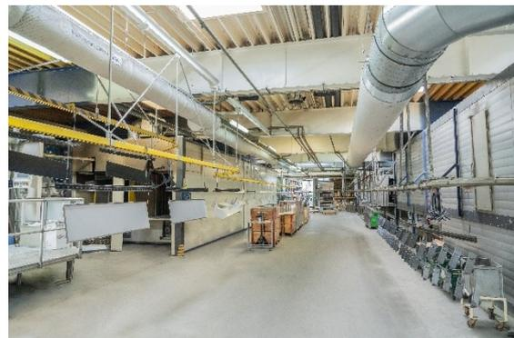
Abbildung 5: Die Textilluftschläuche für die zugfreie Zufuhr der gekühlten Frischluft.
