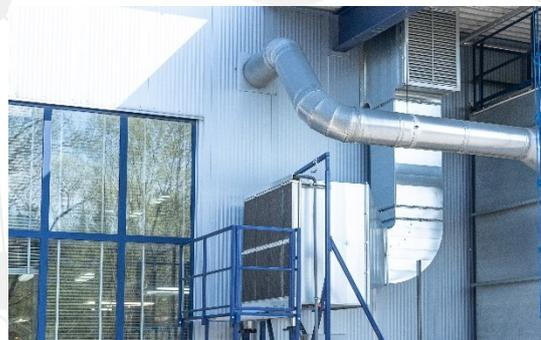
Abbildung 4: Einstufig adiabate Vorkühlung der Ansaugluft des bestehenden Lüftungsgerätes
