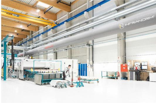
Abbildung 8: Die Lufteinbringung erfolgt mit den individuell gefertigten Textilluftauslässe.
