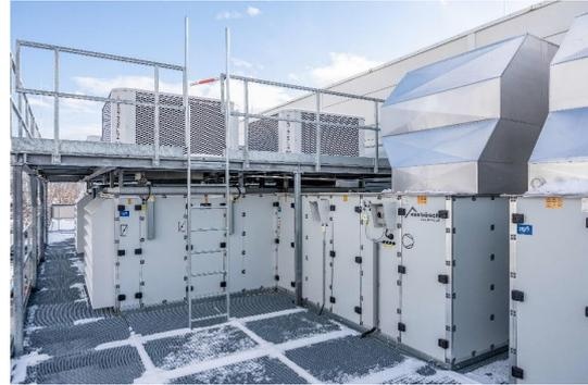
Abbildung 9: Lüftungsgeräte mit aufgesetzten Kühleinheiten zur ganzjährigen Luftkonditionierung.
