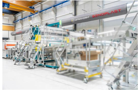
Abbildung 7: Zugfreie Lufteinbringung mit textilen Luftauslässen im Produktionsbereich
