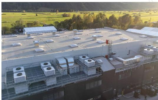
Abbildung 3: Außenansicht der Anlage für bis zu 126.000 m³/h gekühlter Frischluftzufuhr
