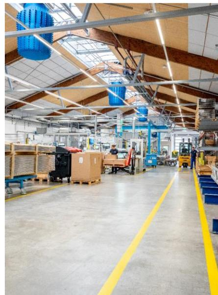
Abbildung 5: Einbringung der Luft in die Halle
