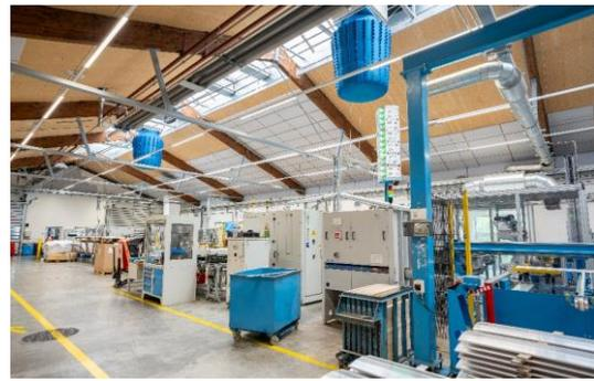
Abbildung 7: Luft-einbringung mit textilen Luftauslässen ohne Verrohrungsaufwand
