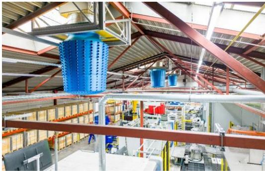
Abbildung 6: Platzsparender Einbau in die vorhandenen Lichtbänder
