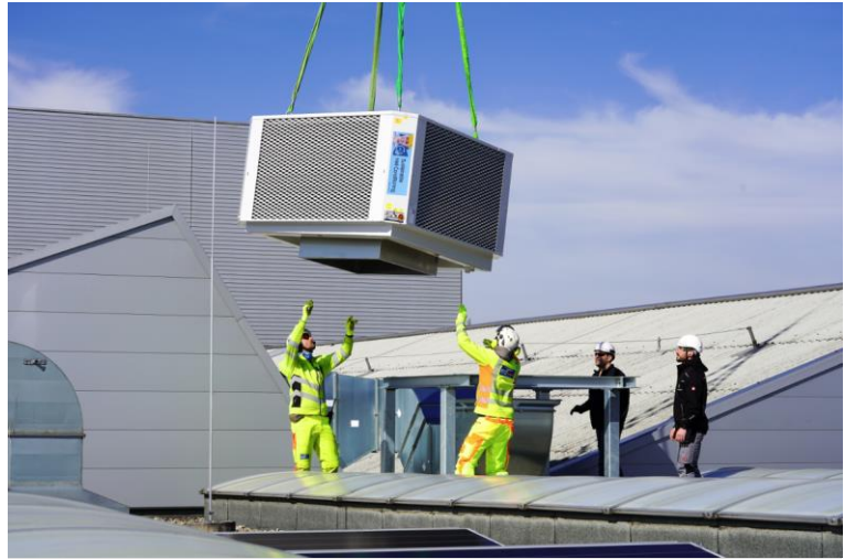
Helikopter Transport der Elemente zur zentral gelegenen Halle.
