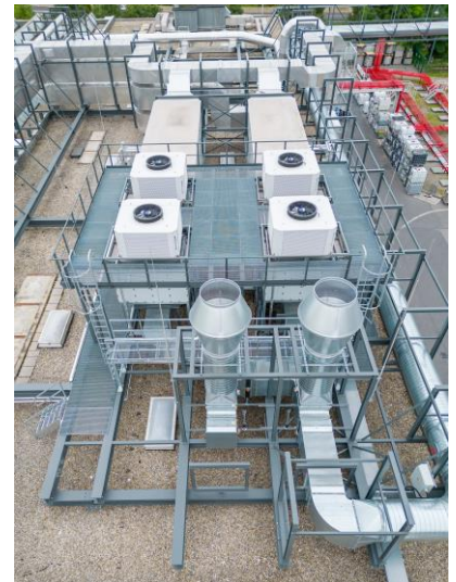
Abbildung 5: Adiabate Kühleinheiten aus der Vogelperspektive
