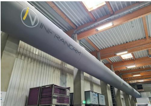
Abbildung 6: Textilluftauslass mit Laserperforierung
