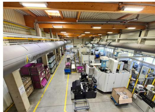
Abbildung 5: Die Textilluftschläuche für die zugfreie Zufuhr der gekühlten Frischluft.
