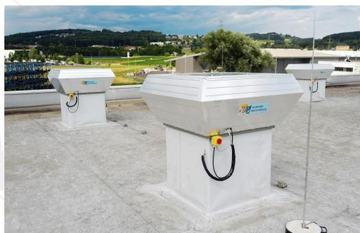
Abbildung 4: Dachventilatoren für die Wärmeabfuhr aus der Halle und die Druckregelung
