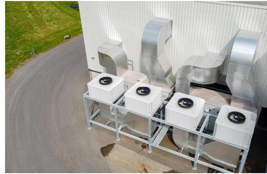
Abbildung 9: Zweistufige adiabate Kühleinheiten mit Lüftungsgeräten und Kanalführung
