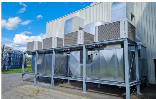
Abbildung 3: Aufstellung der adiabaten Kühleinheiten neben den Lüftungsgeräten
