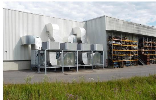
Abbildung 7: Aufstellung der adiabaten Kühleinheiten im Außenbereich
