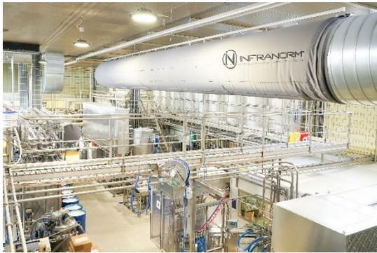
Abbildung 6: In Kühlzonen wird durch Textil Luftschläuche die angenehm kühle Frischluft eingebracht.
