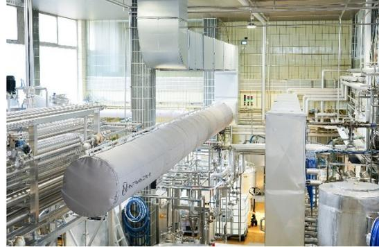
Abbildung 9: Arbeitsplätze werden mittels adiabatem Kühlsystem mit angenehm kühler Frischluft versorgt.
