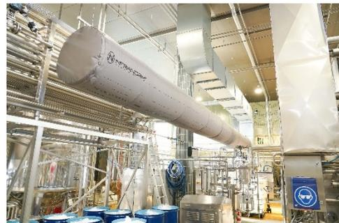
Abbildung 5: Der Textilluftschlauch für die zugfreie Zufuhr der gekühlten Frischluft.
