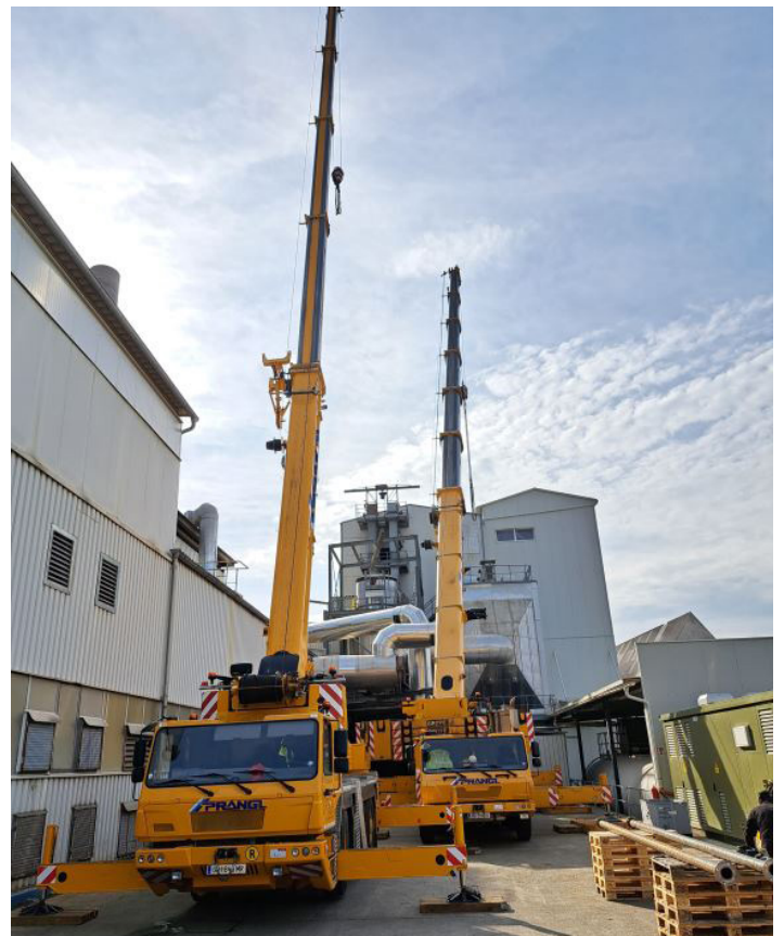
Bild 03 und Bild 04: Für die Arbeiten wurden zwei Kräne eingesetzt: Einer übernahm den präzisen Hub des Wärmetauschers, während der andere für Montagearbeiten mit einem Krankorb genutzt wurde.
