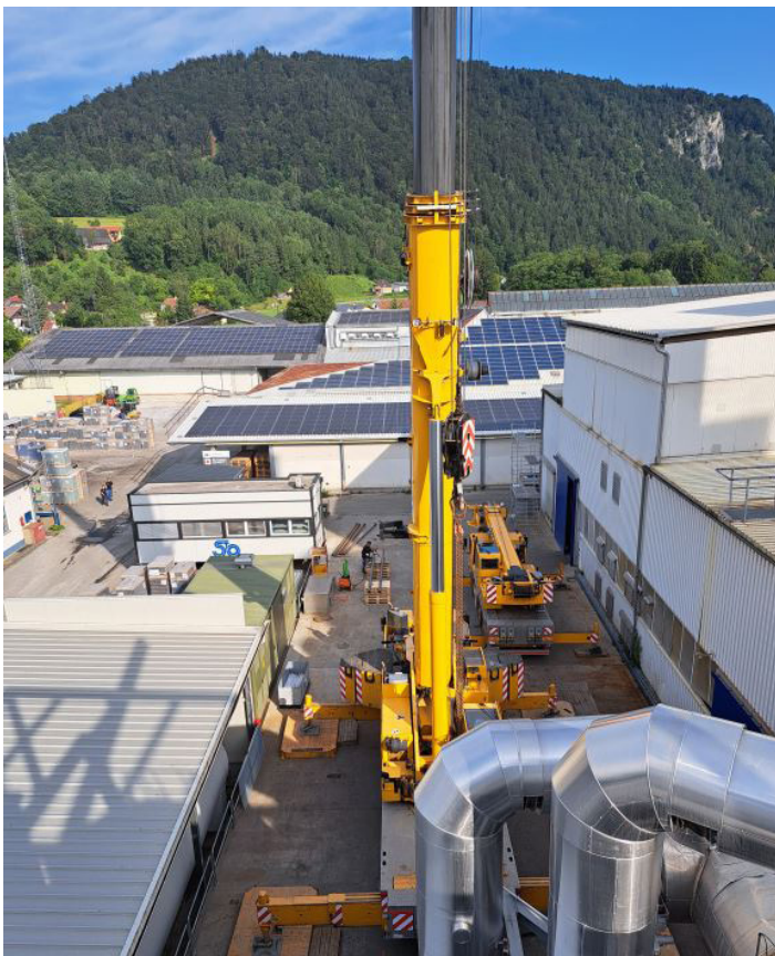
Bild 03 und Bild 04: Für die Arbeiten wurden zwei Kräne eingesetzt: Einer übernahm den präzisen Hub des Wärmetauschers, während der andere für Montagearbeiten mit einem Krankorb genutzt wurde.
