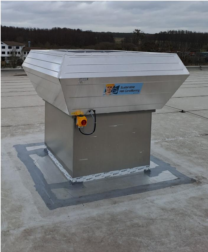
**Bild 02:** Der Abluftventilator befördert die warme Hallenluft nach außen und sorgt somit für eine noch effizientere Kühlung.
