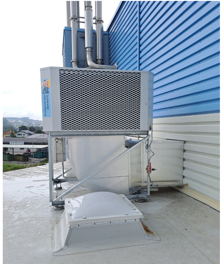
Bild 03: Der zweistufige adiabate Kühler IntrCooll setzt auf die natürliche aktive Kühlung durch Verdunstung von Wasser
