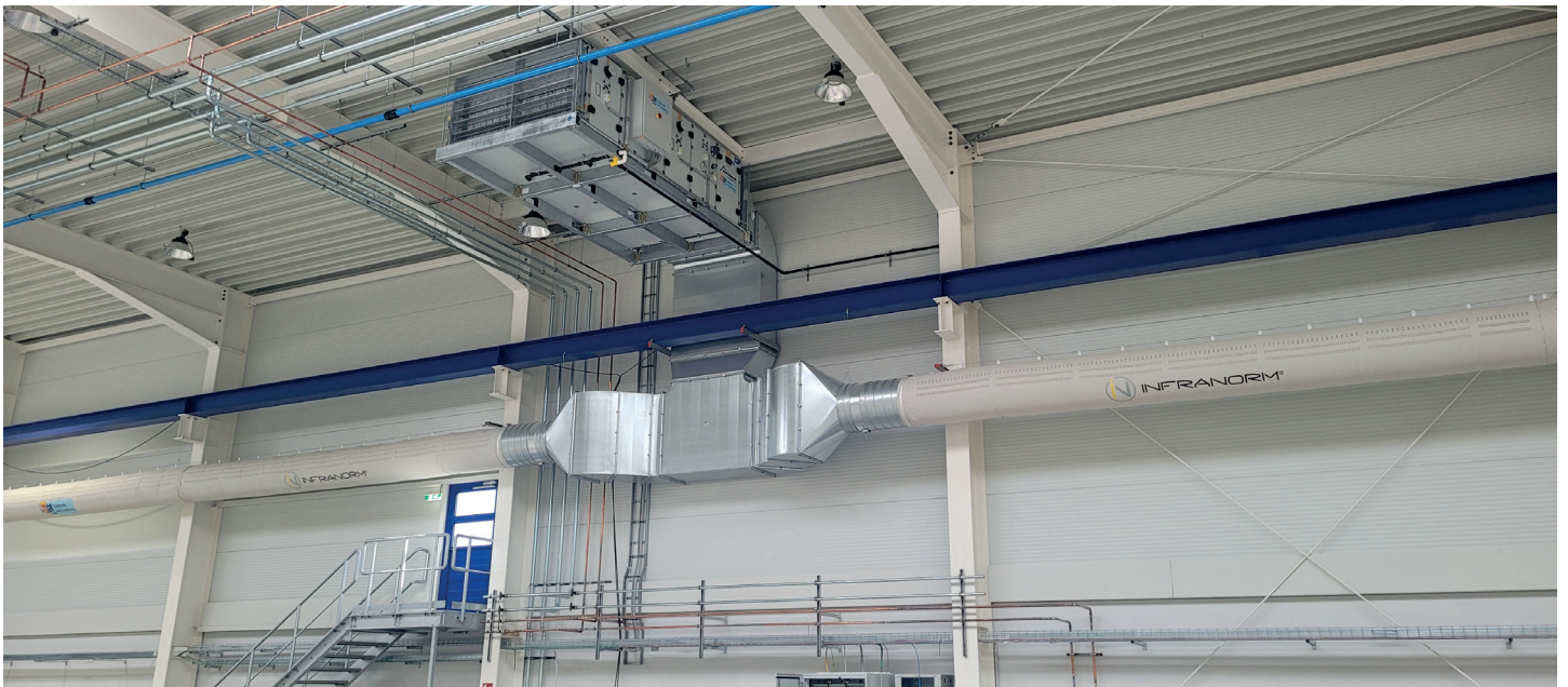
Bild 04: Das textile Zuluftschauchsystem sorgt für eine zugfreie und gleichmäßige Verteilung der konditionierten Luft.
