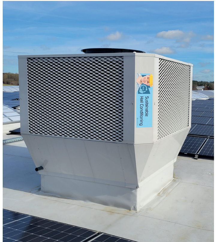
Bild 03: Der zweistufige adiabate Kühler IntrCooll nutzt die natürliche Verdunstungskühlung, um effizient die Temperatur zu senken und den Energieverbrauch zu minimieren.
