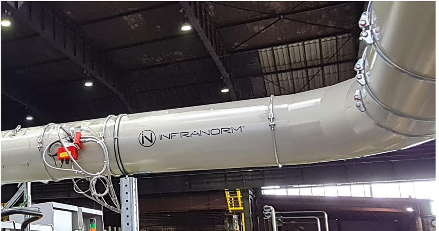
**Bild 02:** Innovatives Absaugsystem mit Funkenmelder zur frühzeitigen Branddetektion
