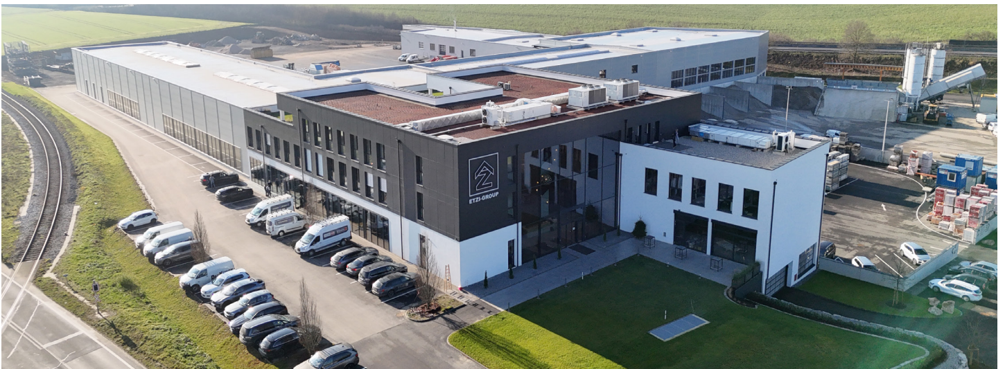
Bild 01: Der neue Firmensitz der ETZI-Group, die ETZI-WORLD, in Ried im Traunkreis – modernstes Firmengelände mit WALLMENT-Ziegelfertigwand-Produktionslinie.
