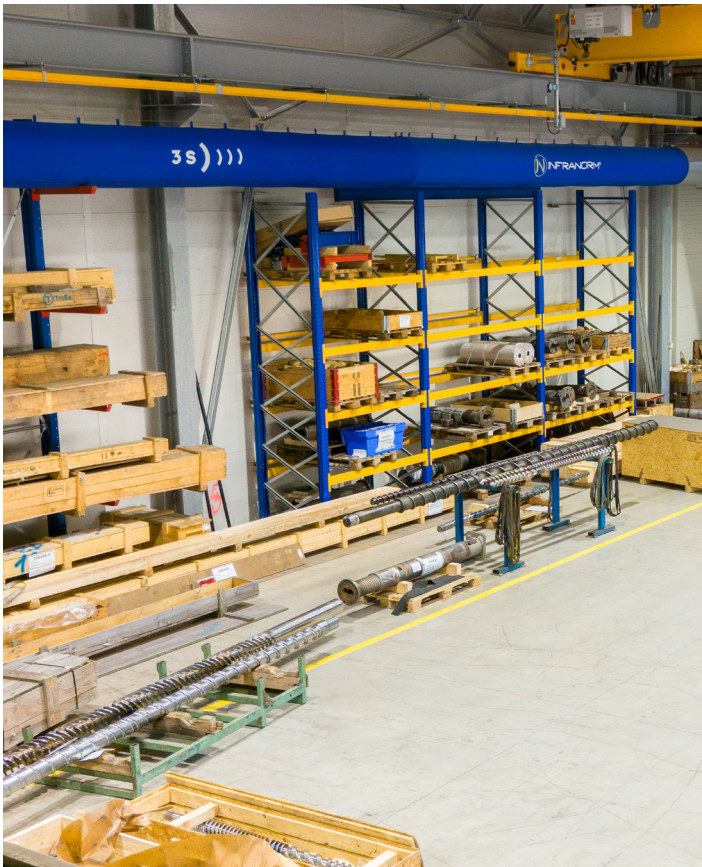
Bild 03: Das textile Zuluftschauchsystem sorgt für eine zugfreie und gleichmäßige Verteilung der konditionierten Luft.
