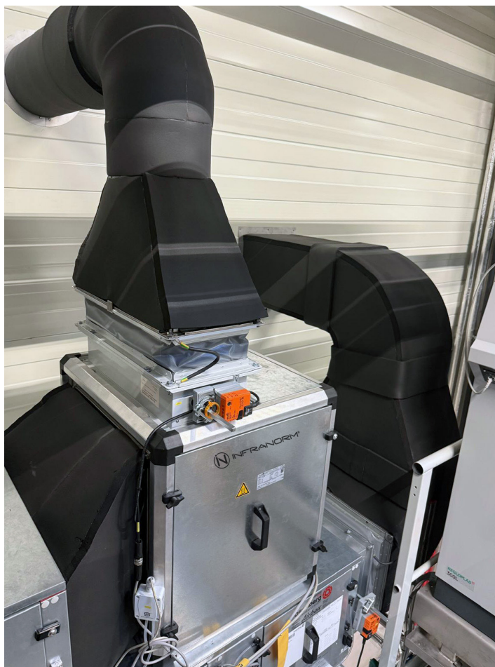
Bild 03: Detailansicht der INFRANORM® Wärmerückgewinnungsanlage in Edelstahl-Ausführung – kompakt, wartungsfreundlich und auf maximale Beständigkeit ausgelegt.
