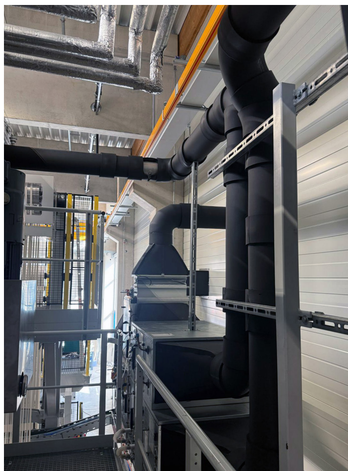
Bild 04: Gesamtansicht der installierten Anlage mit kombinierter Zu- und Abluftführung – präzise integriert in die neue Papier-Trocknungslinie bei IBS Austria.
