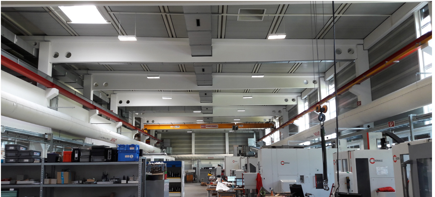
Bild 01: Produktionshalle bei WIHO mit integrierter Hallenkühlung und Frischluftführung zur Sicherstellung stabiler Fertigungsbedingungen
