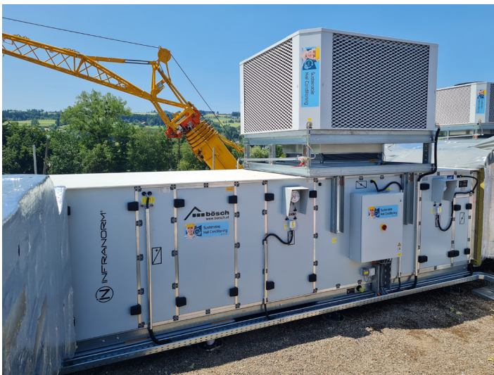
Bild 04: Installation der Hallenkonditionierungsanlage unter projektspezifischen Rahmenbedingungen
