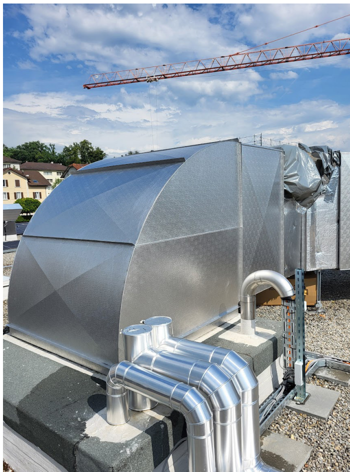
Bild 01: Montage der Hallenkonditionierungsanlage mittels Kran unter laufendem Betrieb
