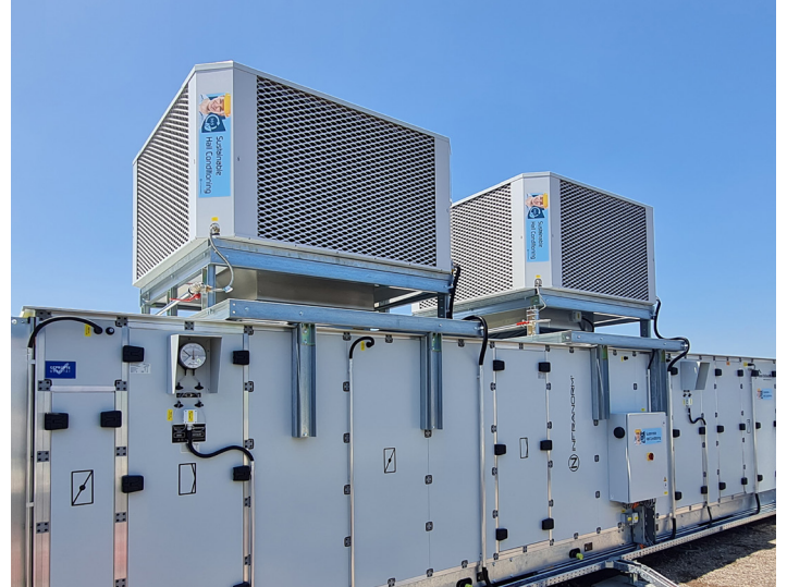
Bild 03: Modulare Hallenkonditionierungsanlage mit adiabater Kühlung und integrierter Systemtechnik
