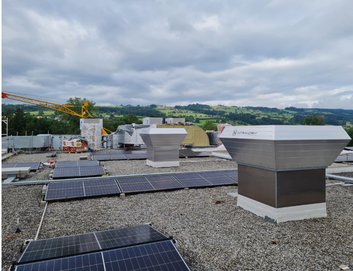
Bild 02: Dachinstallation der Lüftungs- und Kühleinheiten unter Berücksichtigung der Standortanforderungen
