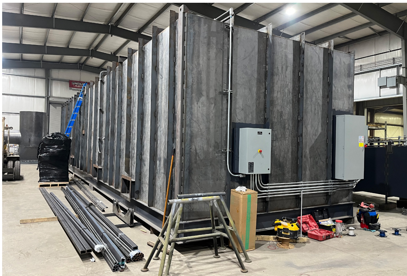
Fig. 1 Por lo general, la instalación de fibra toma lugar en la planta de fabricación de la estructura metálica. Los Módulos MaxBlock son una solución en aislamiento liviana que puede instalarse con mano de obra no especializada.
