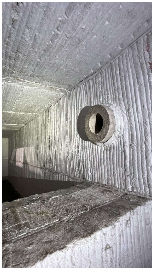
Fig. 3 El sistema de anclajes H permite flexibilidad en la colocación del anclaje para acomodar penetraciones de revestimiento como los bloques de quemadores.
