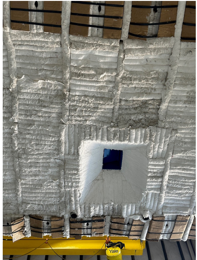
Fig.3 Se pueden proporcionar tamaños de módulos especialmente diseñados para adaptarse a ventanas de inspección, conjuntos de quemadores y otros tipos de penetraciones en el revestimiento.
