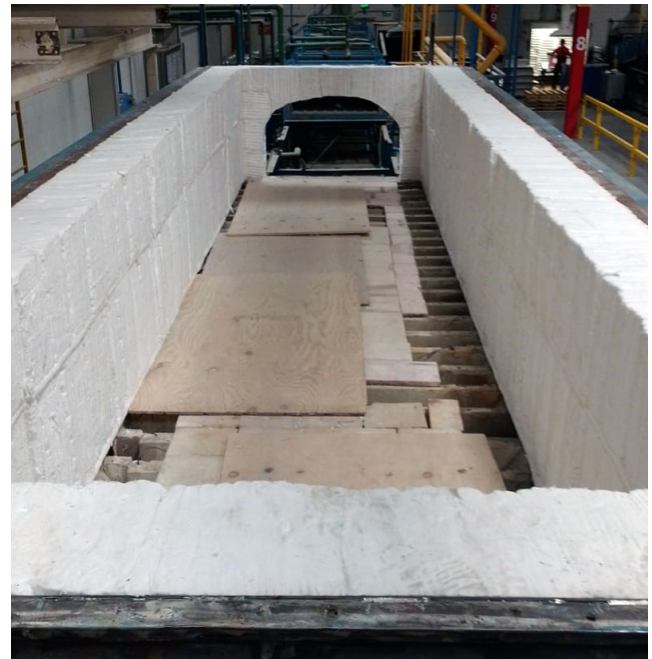
Fig.1 Aplicación de módulos MaxBlock 2600 y rigidizante MaxRigidizer
