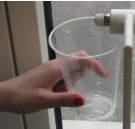
Schritt 3: Behälter direkt unter das Entlüftungsventil halten.
