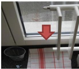
Schritt 2: Handtuch unter Entlüftungsventil legen.
