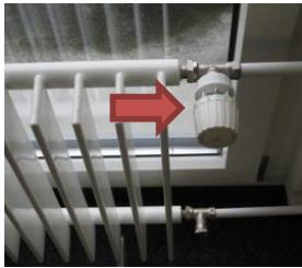
Schritt 1: Heizkörper via Ventil ganz aufdrehen und 5 Minuten abwarten.
