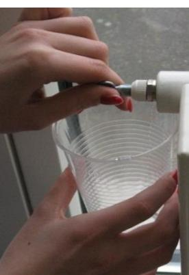
Schritt 4: Entlüftungsschlüssel am Entlüftungsventil ansetzen und dann **langsam nach links drehen** bis es leicht zischt und Luft entweicht.
