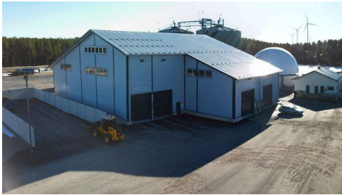
Kuva 1. Gasumin Honkajoen laitos 114 .
