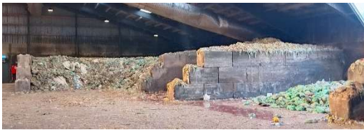
Kuva 6. Ecogin laitoksen erilliskerätyn jätteen vastaanottohalli.
