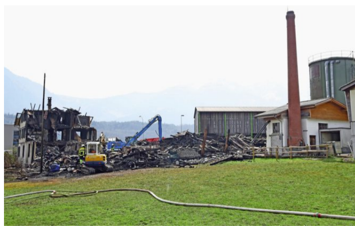
Soll der Kanton eine eigene Gebäudeversicherung betreiben oder sollen weiterhin private Versicherungsgesellschaften Brandschäden wie hier nach dem Grossbrand bei der Firma Schmid Parkett AG übernehmen? Archivbild: Robert Hess (Alpnach, 29. 3. 2022)
