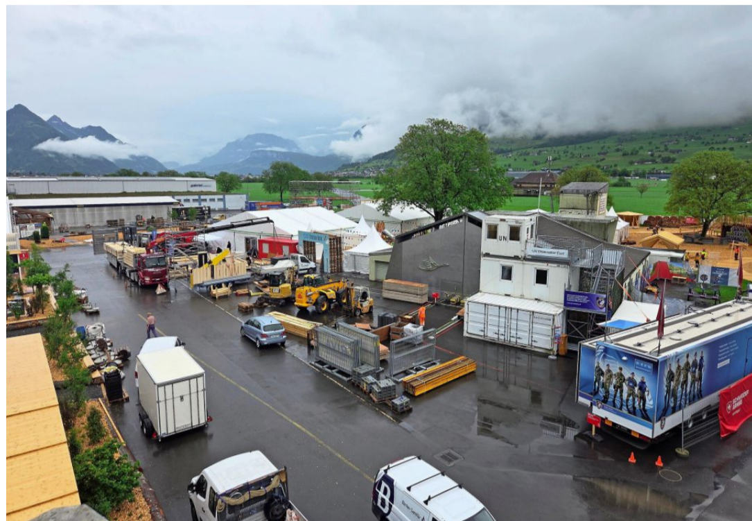
Das Iheimisch-Gelände von oben während der Aufbauarbeiten. Bild: Matthias Piazza (Ennetbürgen, 11. 5. 2026)
