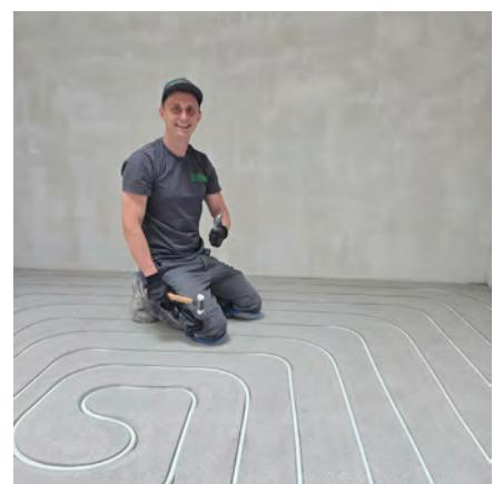
**Bilder rechts:** Die hochwertigen und langlebigen Aluverbundrohre werden sorgfältig in die präzise gefrästen Rillen verlegt. Eine zusätzliche Aufbauschicht ist nicht nötig.
