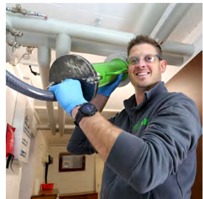
Gerätschaften für die Sanierung mit dem HAT-System / Mitarbeiter beim Sandstrahlen und anschließenden Beschichten der Leitungen
