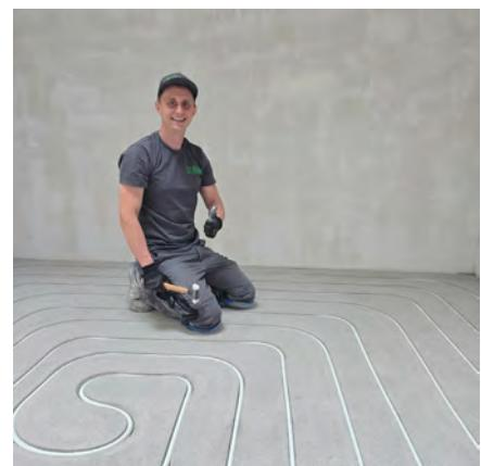
**Photos à droite:** les tuyaux multicouches de haute qualité et à longue durée de vie sont soigneusement posés dans les rainures fraîchement creusées avec précision. Une couche supplémentaire n'est pas nécessaire.
