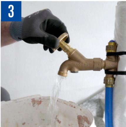
Un dispositif provisoire d'alimentation en eau potable (3) assure le fonctionnement presque comme au quotidien du bâtiment.
