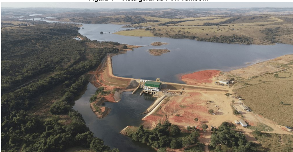
Figura 1 – Vista geral da PCH Tamboril
