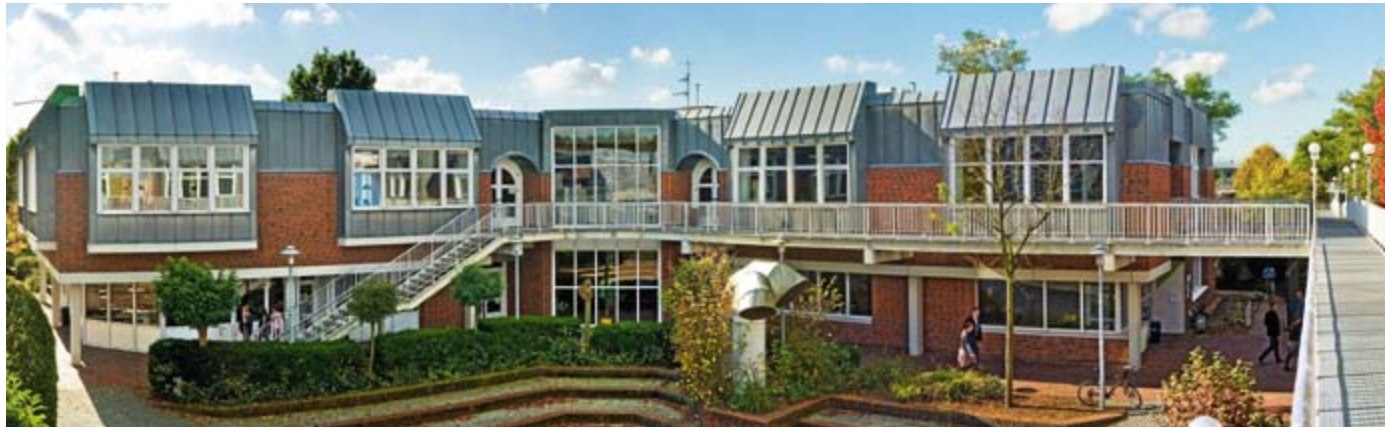
Am 1. April 2019 wird die Mensa Vechta planmäßig und neu saniert wiedereröffnet.
