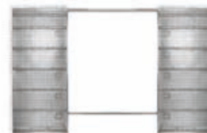
ściana z mokrym tynkiem
